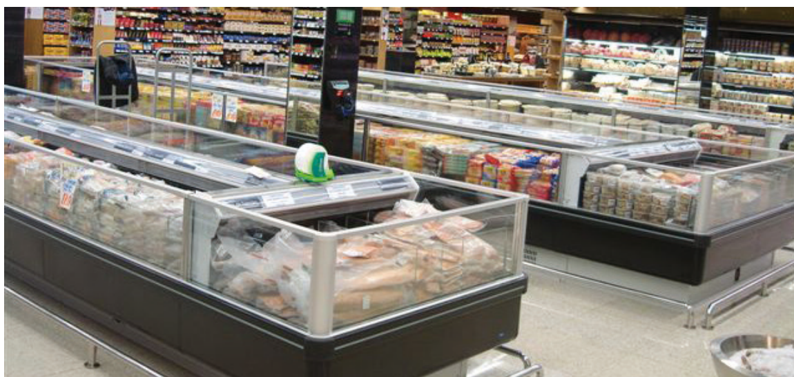
Figura 10.2 - Setor de congelados do Supermercado & Padaria Verdemar, ilhas de baixa temperatura com CO 2 .
