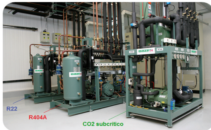
Figura 8.1 - Detalhe dos equipamentos avaliados energeticamente. (Fonte: BITZER)
