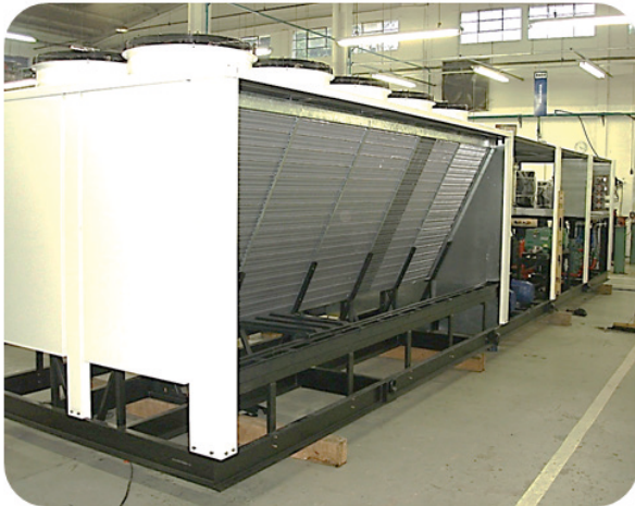
Figura A3.10 - Rack-house com CO 2 / R134a subcrítico. (Fonte: Plotter-Racks)
