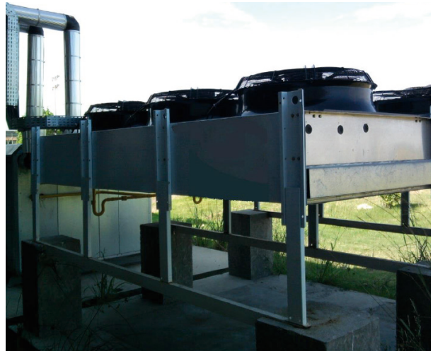
Figura 10.14 – Condensador de ar remoto para R290.
