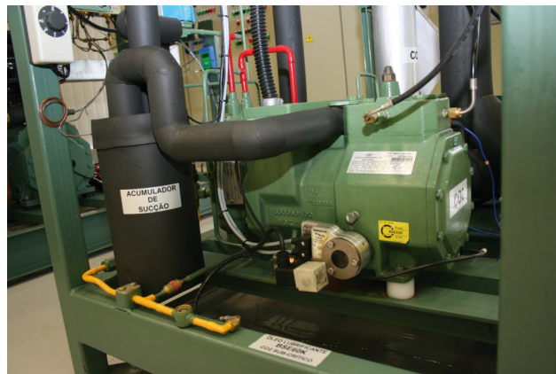
Figura 5.5 - Detalhe do regulador de nível de óleo eletrônico-Traxoil para compressores de CO 2 . (Fonte: BITZER)
