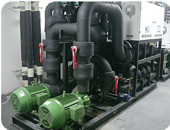
Figura A3.2 - Sistema de bombeamento com glicol. (Fonte: Eletrofrío)
