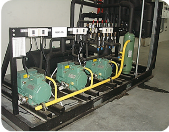
Figura A3.4 - Rack subcrítico com CO 2 , condensação feita com glicol. (Fonte: Eletrofrio)
