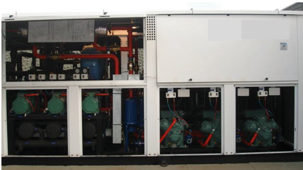
Figura 10.3 - Rack com CO 2 instalado no Supermercado & Padaria Verdemar.
