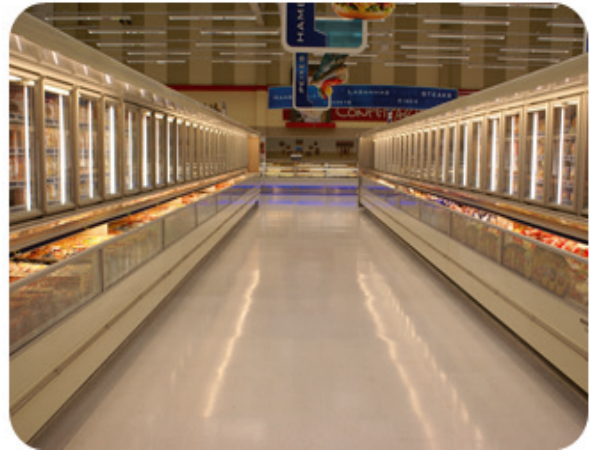
Figura A3.5 - Expositor e ilha de congelados que operam com CO 2 . (Fonte: Eletrofrio)
