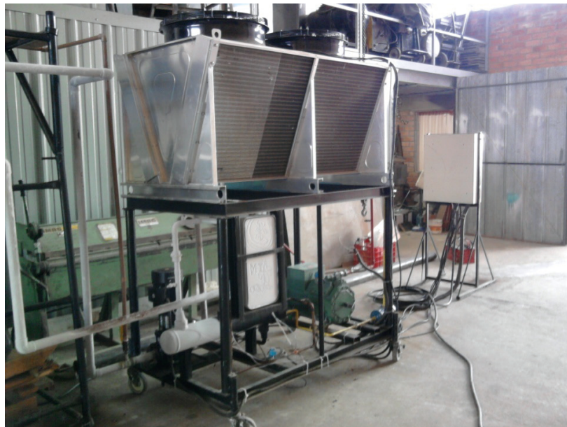
Figura 10.9 - Foto dos equipamentos montados. (Fonte: SPM Engenharia)
