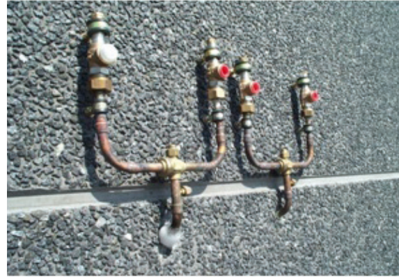
Figura 5.2 - Válvulas de segurança instaladas fora da sala de máquinas, "sem tubulação na saída das válvulas para evitar o bloqueio por gelo".
