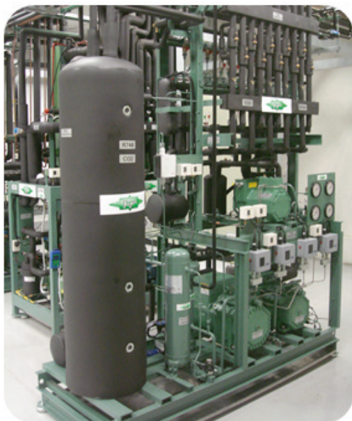
Figura A2.3: Rack de CO 2 transcrito instalado no Brasil. (Fonte: BITZER)
