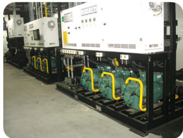
Figura A3.3 - Racks do estágio de alta pressão com R134a. (Fonte: Eletrofrío)
