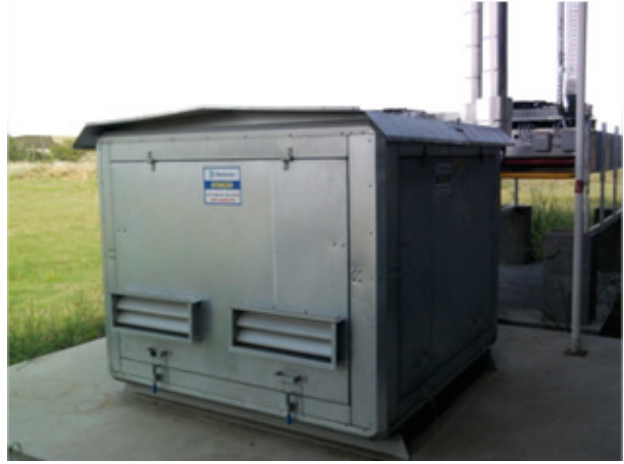
Figura 10.12– Unidade de resfriamento de líquido de R290.
