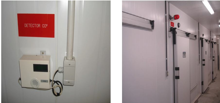
Figura 7.4 - Exemplo de detector de vazamento de CO 2 e alarme visual instalados em câmaras de supermercados com dióxido de carbono – CO 2 .
