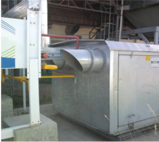
Figura 10.11– Sistema de ventilação da unidade frigorífica de R290.
