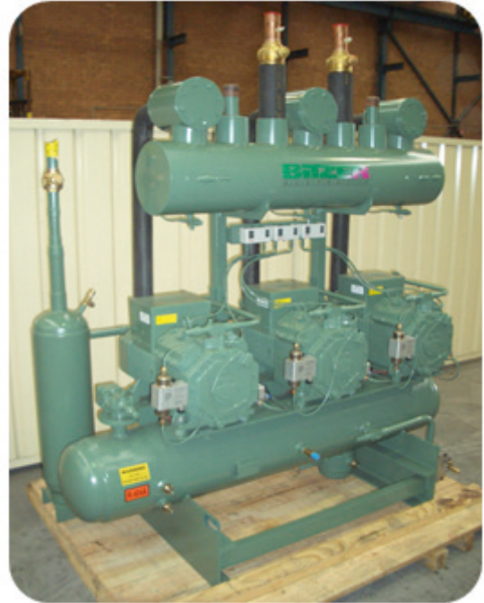
Figura A3.8 - Rack do estágio de alta pressão com R134a. (Fonte: BITZER)
