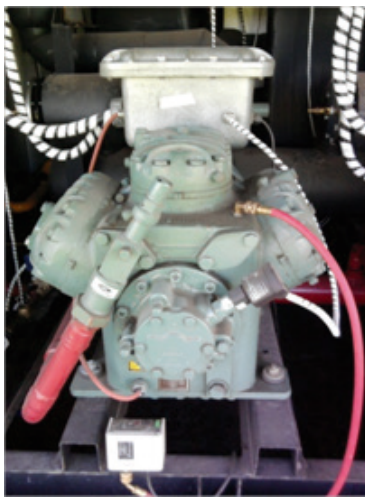
Figura 10.13– Compressor de R290.
