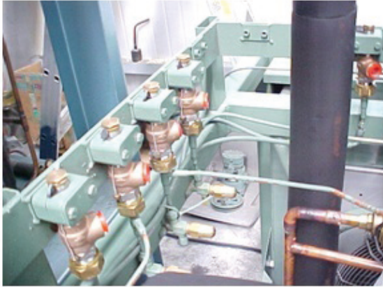
Figura 5.1 - Válvulas de segurança instaladas no rack.
