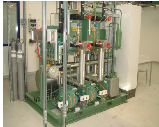
Figura 5.11 - Exemplo de rack com compressores semi-hermético para CO 2 . (Fonte: Bitzer)
